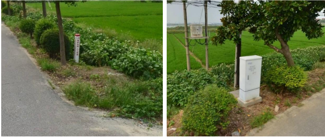
地下埋设联通、电信管线
