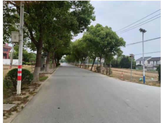
现状莲金支路
