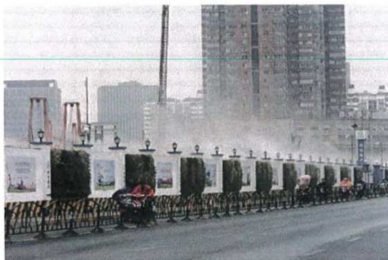
喷雾降尘装置示意图
