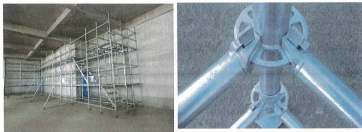
承插型盘扣式脚手架示意图
