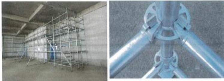
承插型盘扣式脚手架示意图
