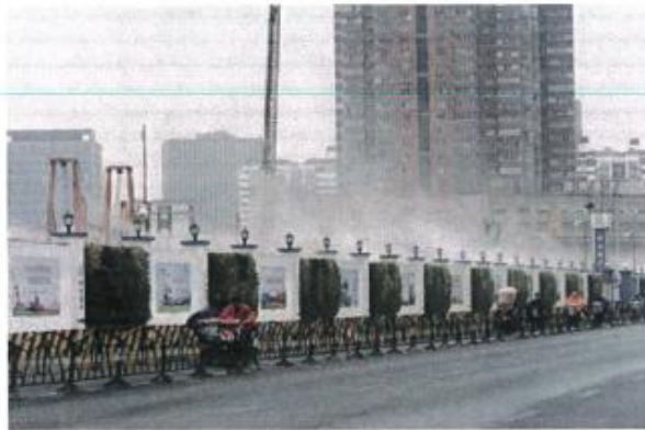
喷雾降尘装置示意图
