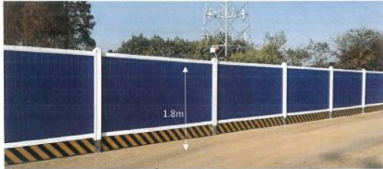
管线工程、架空线入地和合杆整治工程围挡示意图
