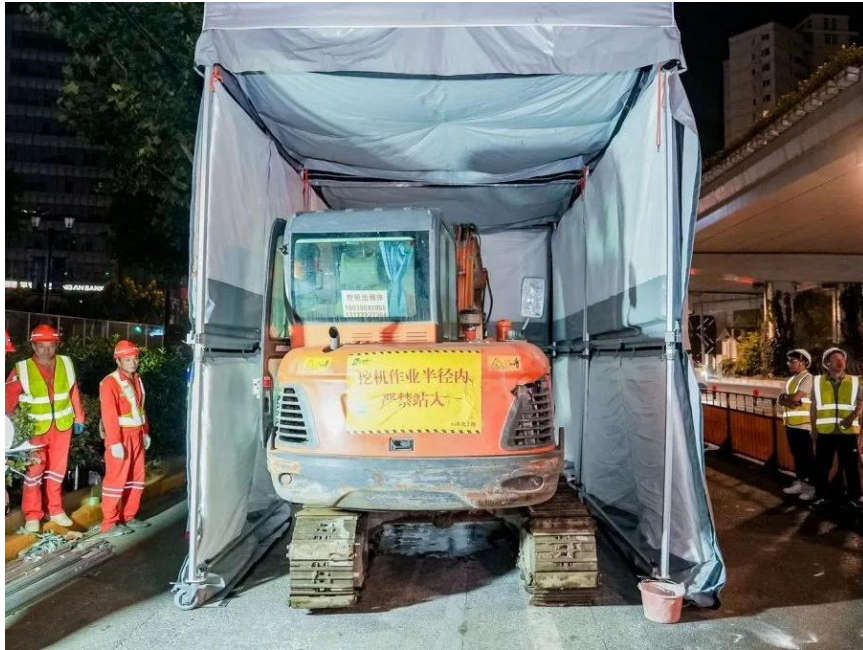
隔音罩法施工
