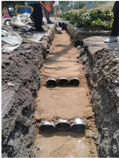
排管施工照片（三）
