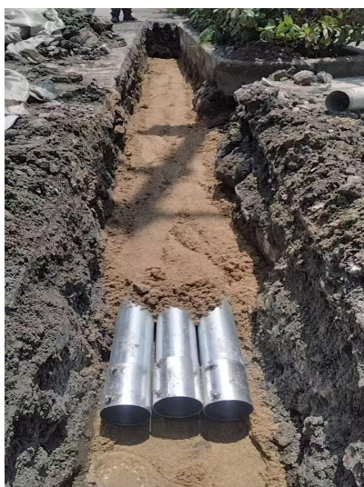
排管施工照片（二）
