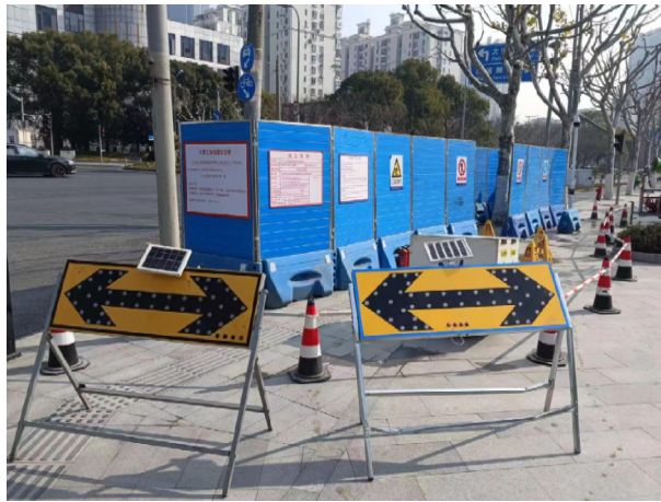
施工现场高围挡
