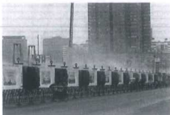
喷雾降尘装置示意图
