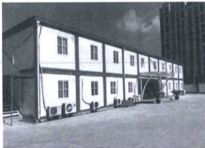
箱式钢结构临时房示意图
