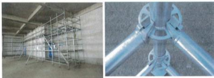
承插型盘扣式脚手架示意图
