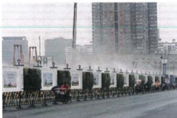
喷雾降尘装置示意图
