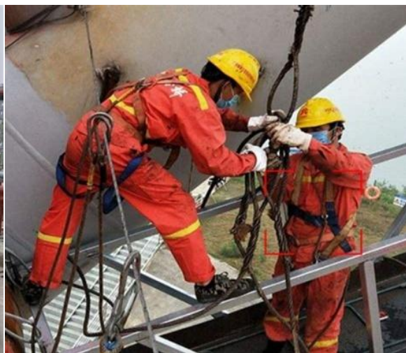
高空作业安全带穿戴检查
