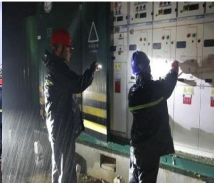
暴雨前配电箱断电
