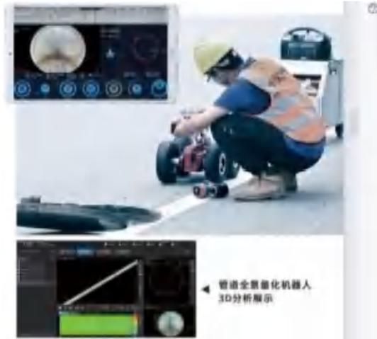
CCTV 检测机器人部件检查
