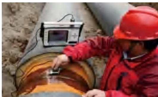
老旧管道无损检测
