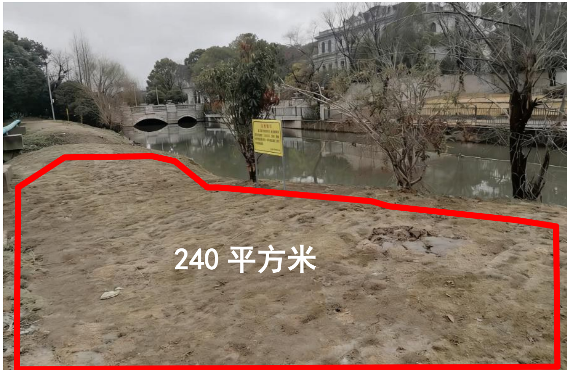
南片区河道相关设施维修点位
