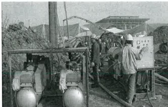
套管内桩外侧泥土冲刷清洗
