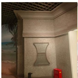
四层工艺馆现状
