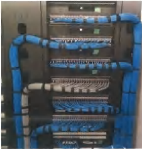
弱电间理线架安装
