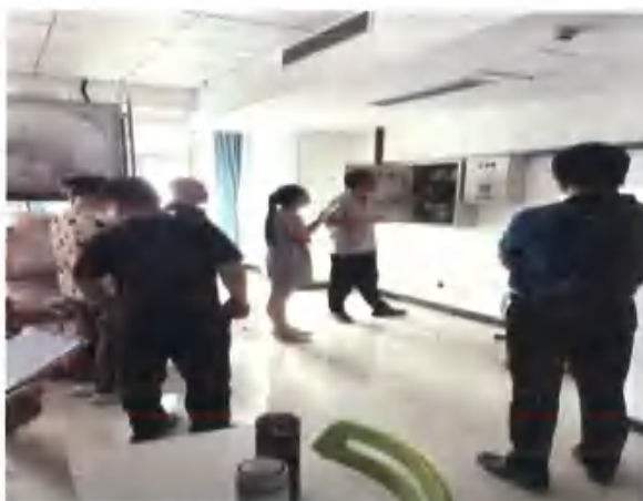
现场维保汇报
