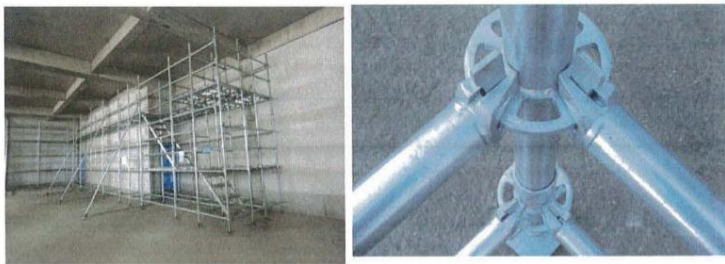
承插型盘扣式脚手架示意图
