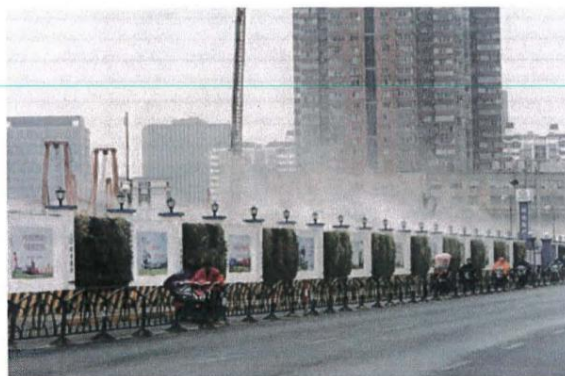
喷雾降尘装置示意图
